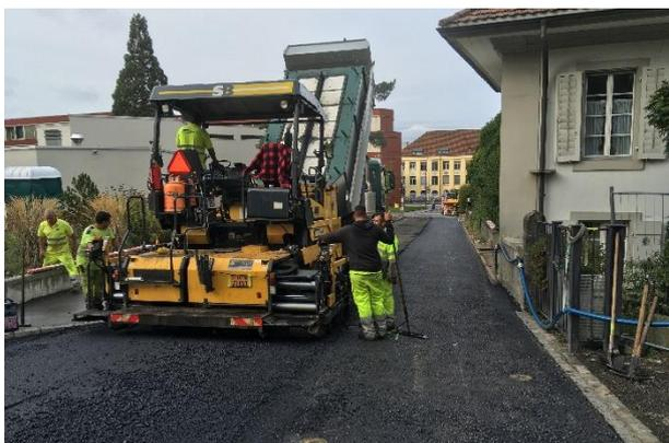
Einbau der Tragschicht in der Bottensteinerstrasse
