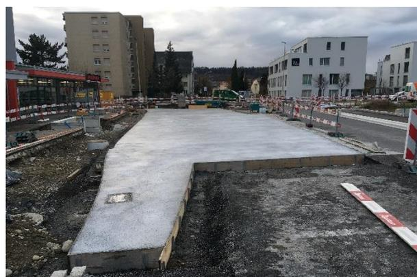
Der Kreisel wird betoniert, da Beton dauerhafter ist als Asphalt
