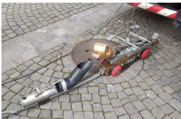
Mit einem Roboter wird der Zustand und die Lage der Hausanschlüsse erfasst
