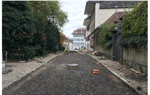
Die Foundation ist vorbereitet für das Versetzen der Kopfsteinpflasterung
