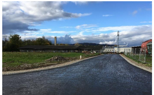
Neue Erschliessungsstrasse Brühlmatten in Richtung Parzelle 3814
