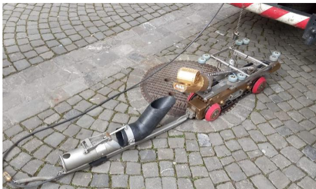
Mit einem Roboter wird der Zustand und die Lage der Hausanschlüsse erfasst
