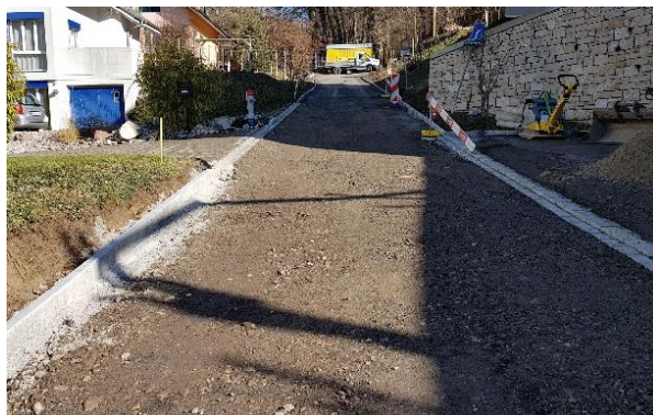
Im Hirschkampweg mussten die Werkleitungen erneuert werden
