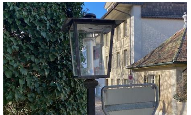
Die bestehenden Stehleuchten wurden mit einem LED-Einsatz mit warm-weissem Licht ausgestattet
