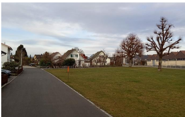
Das Strassenabwasser wird neu in der Badi-Wiese versickert
