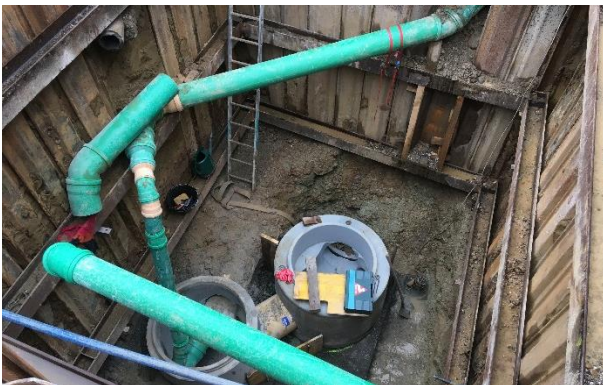
Übergangsschächte und provisorische Leitungen als Vorbereitung für die neue Kanalisation
