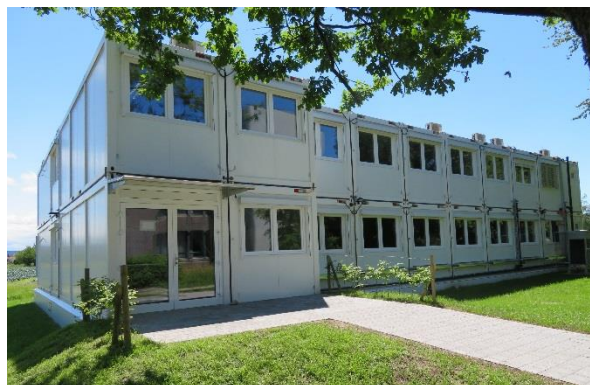
Das Schulraumprovisorium im Grünen erfreut sich bei der HPS während der Bauphase grosser Beliebtheit
