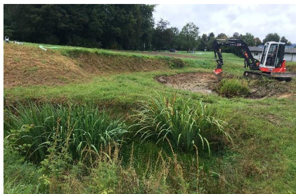
Sanierung der verlandeten Weiher beim Schützenhaus Heitern
