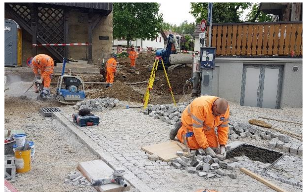
Beim Pulverturm wird die letzte Asphaltfläche der Altstadt mit Pflastersteinen ersetzt
