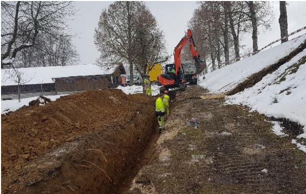
Auf dem Heitern galt es, die veralteten Leitungen für Strom, Wasser und Abwasser zu sanieren
