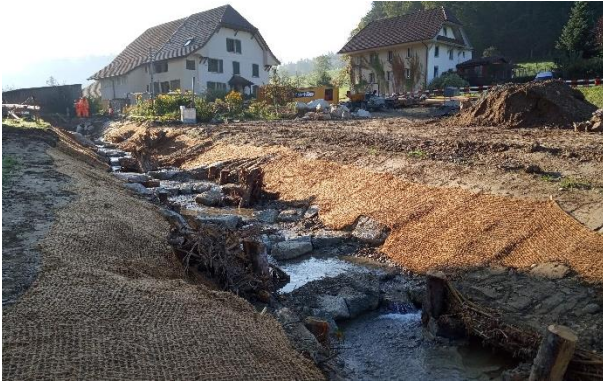
Der letzte Abschnitt des Riedtalbachs wurde ausgedolt und renaturiert
