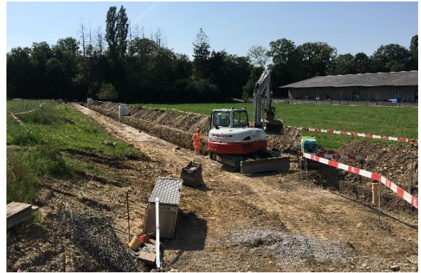
Neue Kanalisation entlang der Parzelle 3814
